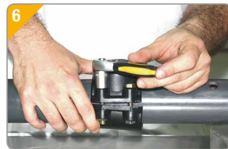
6. Ayudarse de las herramientas pertinentes para que la tornillería quede ajustada hasta su tope , de este modo no se producirán movimientos en el collarín por golpes de ariete.
