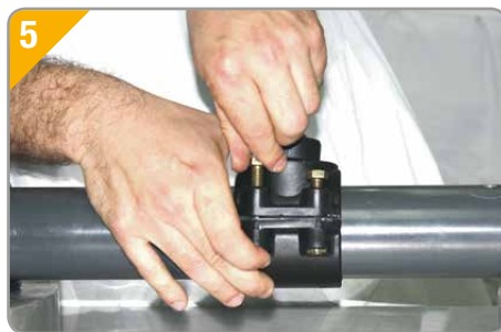
4. y 5. Apretaremos los tornillos de forma progresiva y alternativa para lograr un apriete uniforme.
