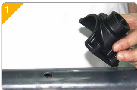
1. Tomando como base la boca del collarín, marcaremos el agujero , y procederemos a realizar el orificio.
