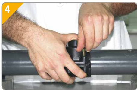
4. y 5. Apretaremos los tornillos de forma progresiva y alternativa para lograr un apriete uniforme.
